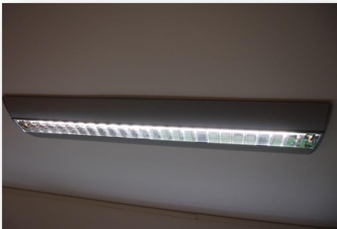
die Deckenleuchte die Deckenleuchten
